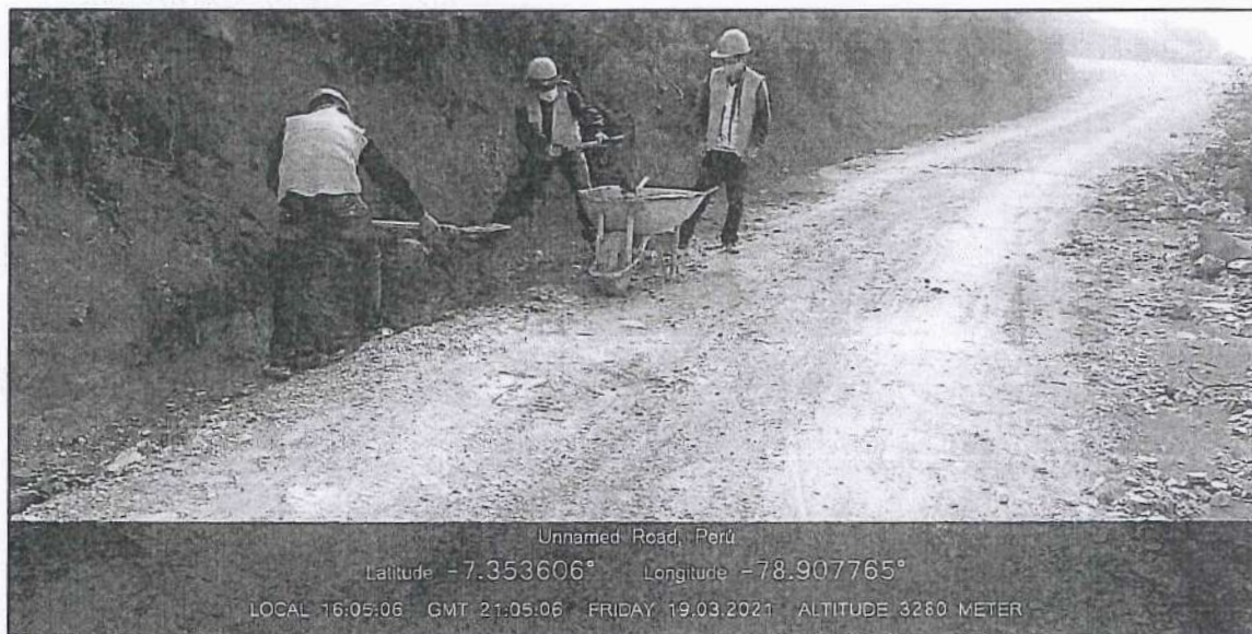
Foto N° 02: Limpieza de cunetas.
