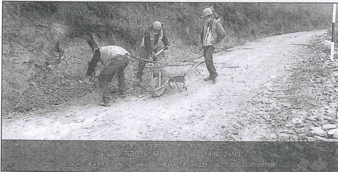
Foto N° 05: Remoción de derrumbes.
